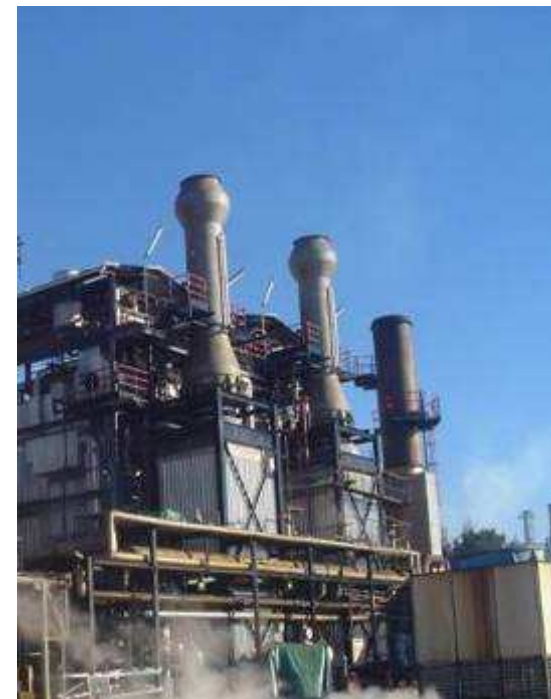
INA – RAFINERIJA NAFTE HRVATSKA Industrijski kotao na loživo ulje 44/50 MWe
