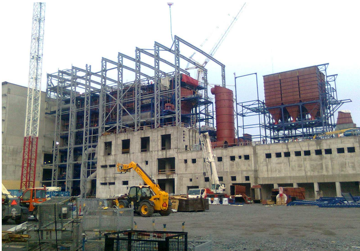
Vaasa, Finska Kotao na otpad - spalionica smeća
