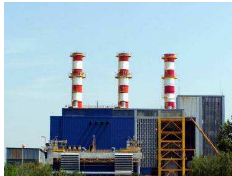
EL-TO Zagreb Kombinirano kotlovsko postrojenje
