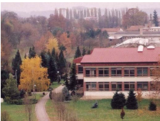
Slika 8. Šumarska i drvodjelska škola u Karlovcu (Foto: Dubravko Halovanić)
