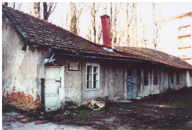
Slika 9. Dvorišna zgrada u Rakovcu 2, oštećena u Domovinskom ratu (Arhiv: OŠ "D. Jarnević", Karlovac)
