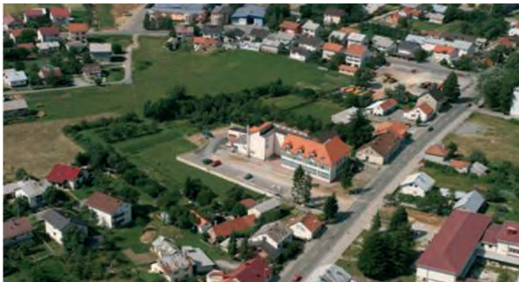
Slika 1. Toplana na biomasu i upravna zgrada UŠP Gospić
