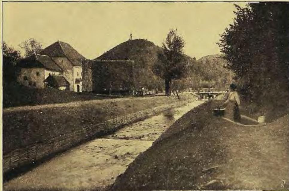
Regulacija potoka na materialnem stožcu. Correction d'un ruisseau sur le lit de déjection
