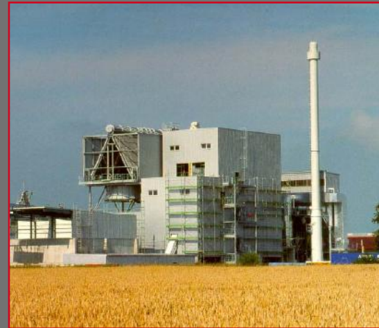
Energana na biomasi 25 MW th , Großaitingen, Njemacka
