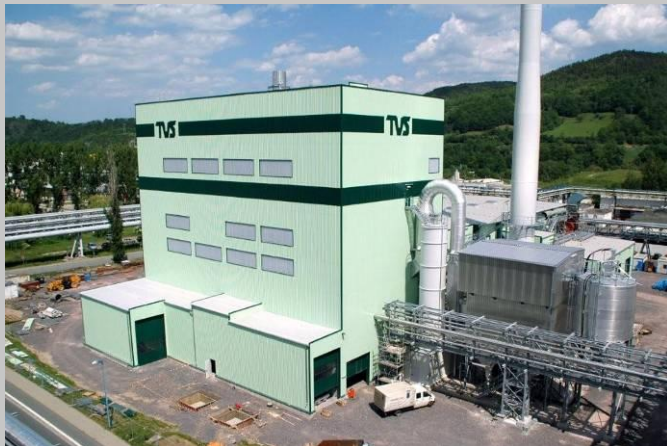
Spalionica otpada/toplana Zaso, Njemačka
