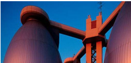
Pročistač voda Emschermündung, Njemačka 4 x TBG 620 V16 K, plin iz pročistača, 5 MW
