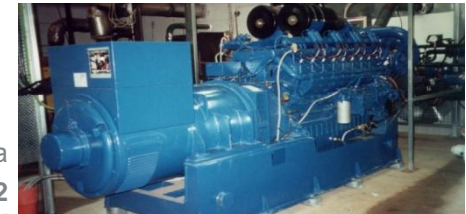
Bramberge, Njemačka 2 x TBG 616 V16 K, plinovi dobiveni iz prerade nafte, 1,2 MW
