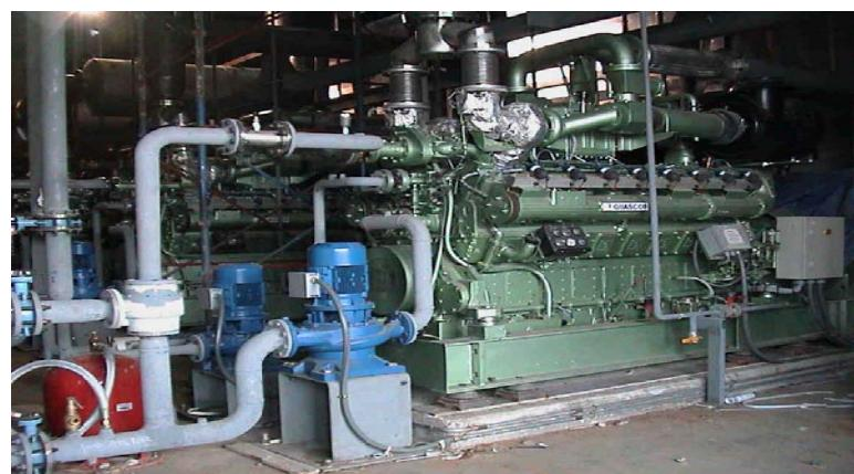
Toplina proizvedena na elektroenergetskoj jedinici kao nus proizvod koristi se za sušenje goriva i za grijanja za vlastite potrebe
