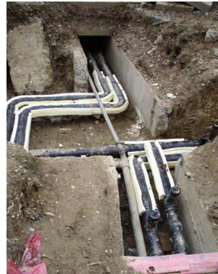
Cijevi postavljene na poliuretanske gradice zagriju se vrelom vodom zbog predistezanja i potom zatrpuju pijeskom odgovarajuće finoće, postavlja se upozoravajuća traka i zatim se zatrpuju zemljom. Cijevi se međusobno povezuju zavarivanjem pod zaštitom argona (nužan je atestirani zavarivač).
