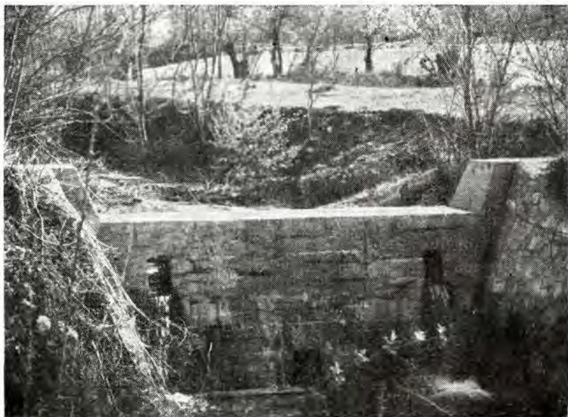
Sl. 5. Pregradni prag za stabilizaciju bujičnih nanosa
