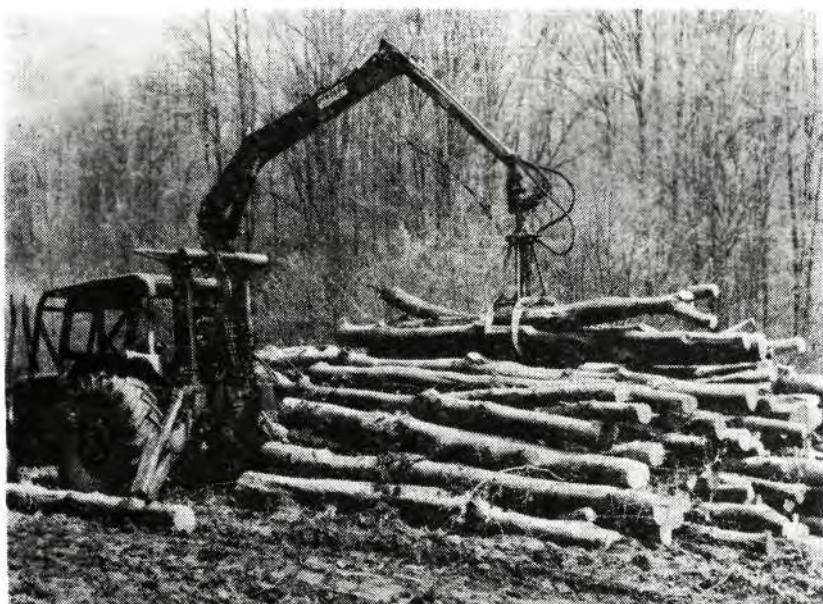
Sl. 6. Traktor IMT — 558 s dizalicom KCR — 2000 uhrpava v.m. drvo na pomoćnom stovarištu.
